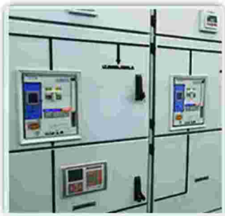
LV Switchgear
